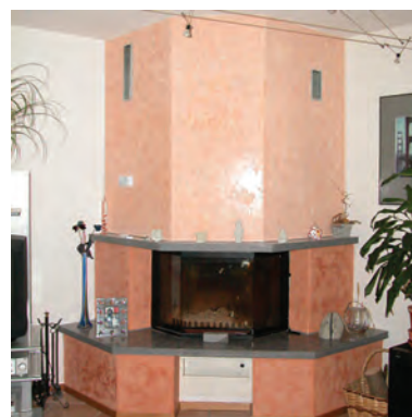
Lisciatura di un camino (in una casa privata) con stucco veneziano a tre tonalità, 2004
