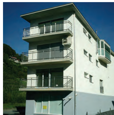
Isolazione in polistirolo di una palazzina a Roveredo (progettata dall'architetto Aris Tognola), 2006
